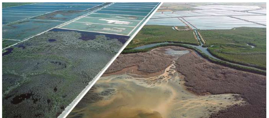
Como consecuencia del desarrollo de granjas, se ha documentado la mortandad de manglares, debido a la alteración de las condiciones hidrológicas y contaminación del agua por el desecho de aguas provenientes de las granjas camaroneras.
