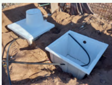
Armado de los baños previo a su instalación y colocación de los contenedores para contención de residuos orgánicos en Sonora.
